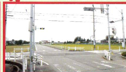
令和2年3月 井口町(出会い頭) 井口東交差点
