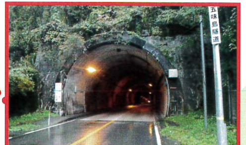
令和2年11月 釜谷(正面衝突) 五味島トンネル内
