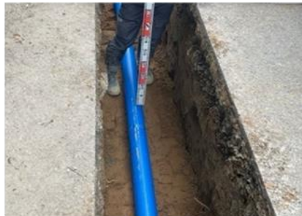
水道管の耐震化
