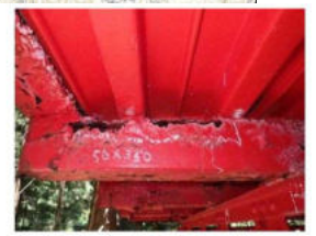
写真-4.4.1 損傷状況(横梁孔食)
