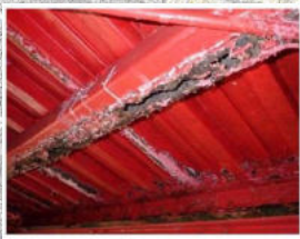
写真-4.4.1 損傷状況(横梁孔食)
