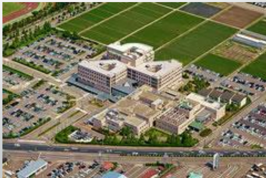
公立松任石川中央病院横に建設予定
