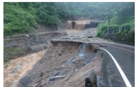
[Ozo] Đường Hakusan Shirakawa-go White Road Dòng sông chảy xiết, gây sạt lở đường. Vì cơ sở khai thác nước bị thiệt hại, nên khu vực Ozo đã xảy ra tình trạng mất nước.
