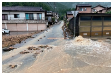
【鹤来朝日町】 侧沟泛滥，导致道路积水。
