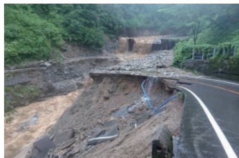
【尾添】白山白川乡白色公路 河流流速加快，冲毁了道路。取水设施受损，导致尾添地区停水。
