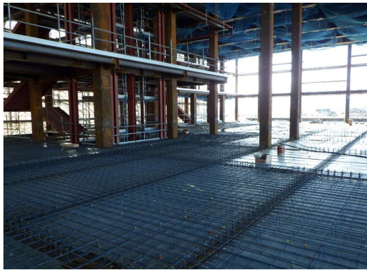
3階では、床にコンクリートを打つための鉄筋を組んでいます。
