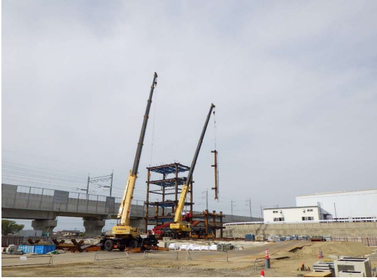
建物の柱を建て始めました。
