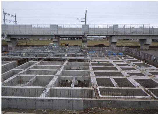
建物（室内部分相当）の基礎コンクリートが完成しました。
