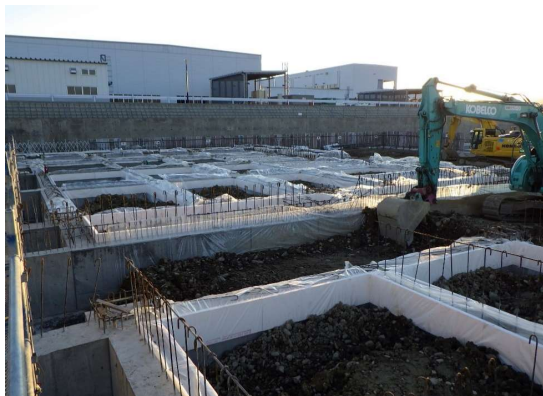
基礎の埋め戻しを行っています。
