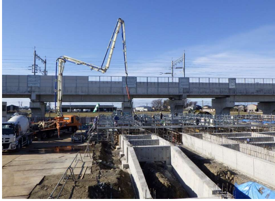
地中梁コンクリートを打設しました。(B-2工区)
