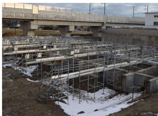
地中梁のコンクリ打設を行い強度確認をして型枠を外しました。
