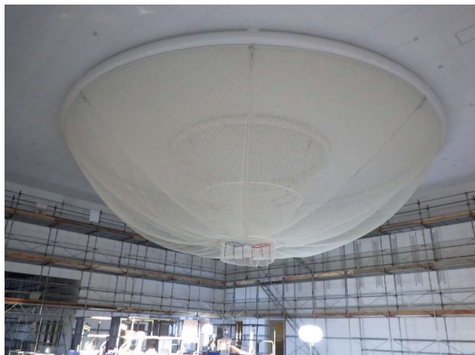
3階屋内遊具の設置工事を進めています。 お椀型のネットが天井から吊り下げ られました。
