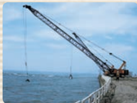
美川漁港のしゅんせつ工事
