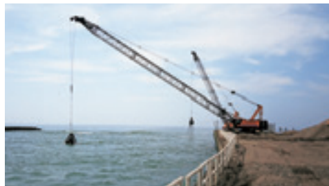
美川漁港の しゅんせつ工事
