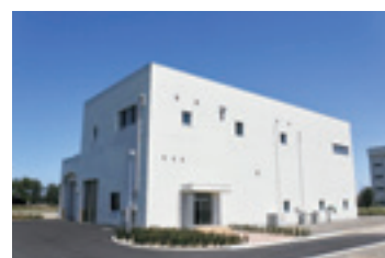
し尿・浄化槽汚泥受入施設
