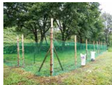
防護柵の設置
