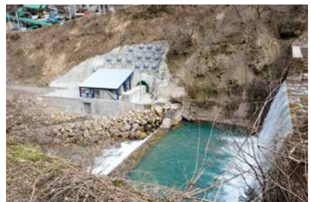
小水力発電所
