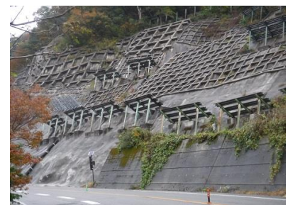
【斜面对策】 (東二口町)
