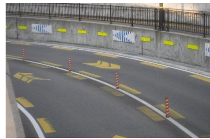
【ドットライン・視線誘導標】 (西新町地内)
