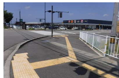
【視覚障害者誘導用ブロック】
