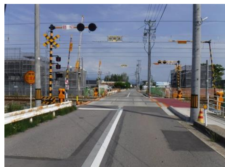
【宮野前踏切（宮保町地内）】
