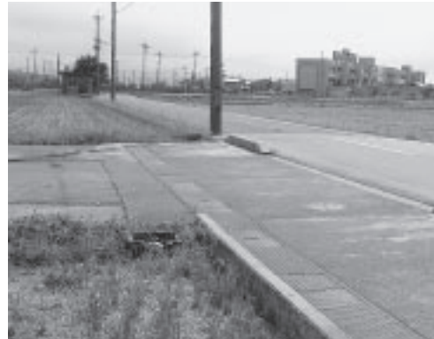
歩道の建設が待たれる通学路
