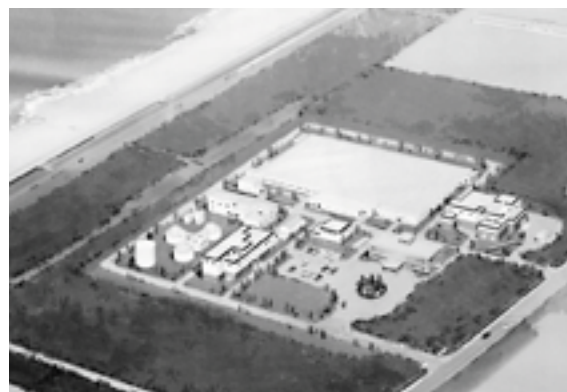
処理費用57円/㎡の翠ヶ丘浄化センター
