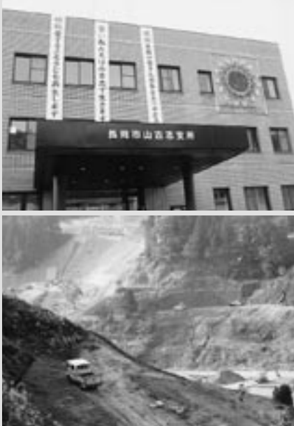
急ピッチで災害復旧が進む旧山古志村
