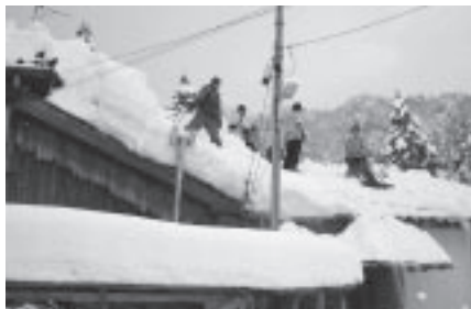
ボランティアによる屋根雪下ろし
