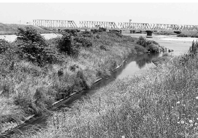
水門設置を待つ河川合流点
