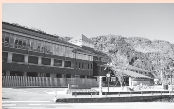
平成20年11月に竣工した白嶺小中学校
