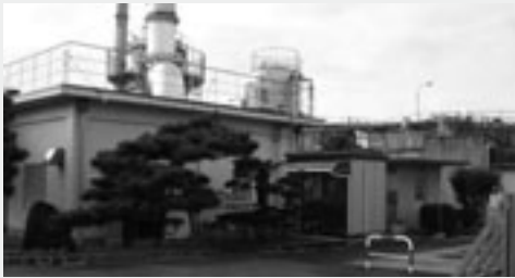
老朽化している松任衛生センター
