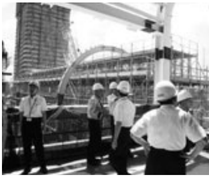
工事中のJR久留米駅を視察
