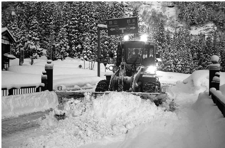
白峰地区での除雪作業
