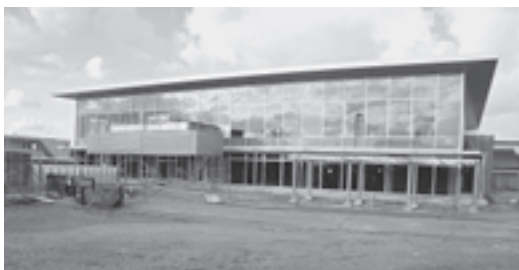
現在建設中の市福祉ふれあいセンター
