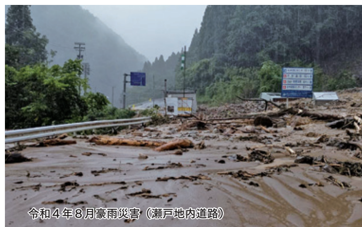
令和4年8月豪雨災害（桑島地内道路）
