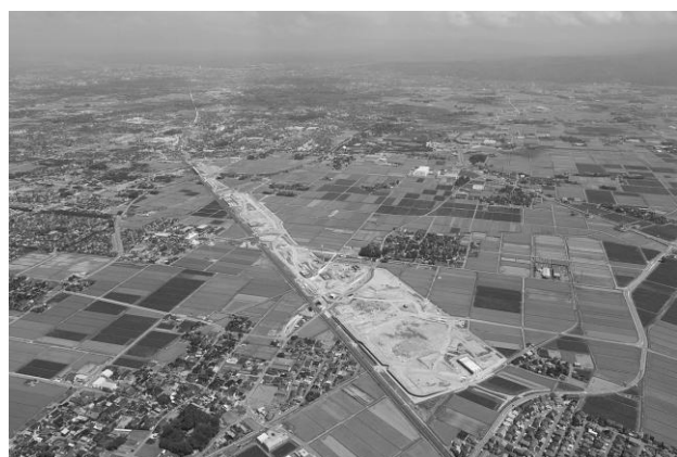
建設中の白山総合車両基地
