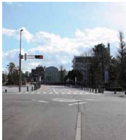
無電柱化が進むまちなみ (燕城通り線)
