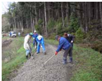
住民参加による農道整備（八幡町）
