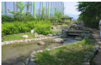
自然とのふれあいの場になるよう、自然石張護岸のせせらぎを整備（山島用水）
