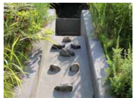
縦排水路の制水工に自然石を使用して自然との一体性に配慮（白峰ノ主要地方道白山公園線）
