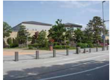
敷地内を緑化し周辺景観との調和に配慮（松任学習会館）
