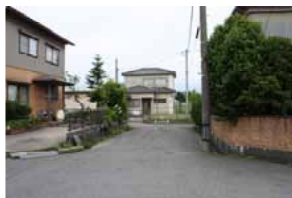
住宅地に立地するため、勾配屋根とし、周辺の住宅と違和感のない外観とした上水道施設（加賀野配水場／柏町）
