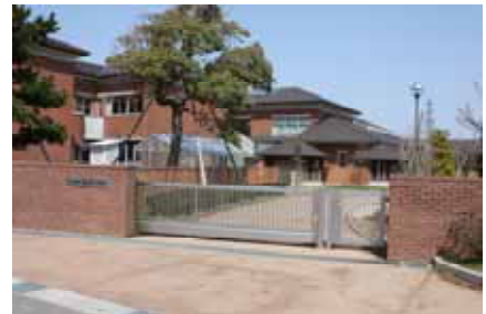
長期間性能を保つことができるレンガを外装仕上げに使用（蕪城小学校）
