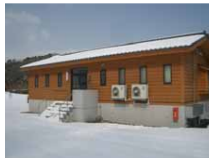
管理棟に県産木材を使用して景観に配慮 (寺田川ダム / 能登町)
