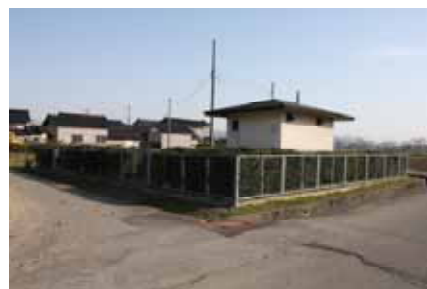
周辺に植栽された農業集落排水処理施設（明法島町）
