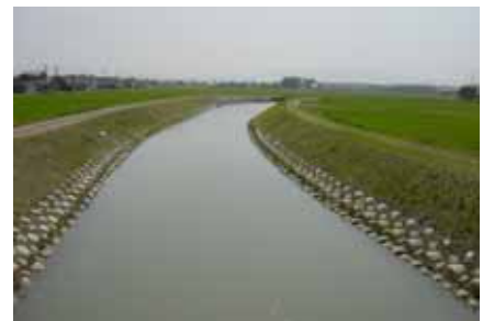
護岸肩部の硬い印象を和らげるよう、護岸天端付近を緑化（倉部川）
