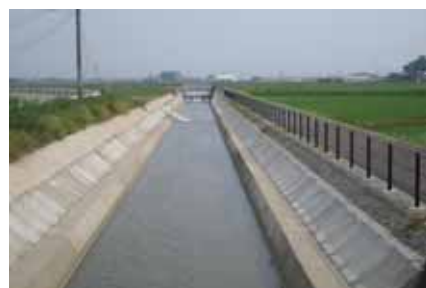
用水路を復断面により整備（中島用水）
