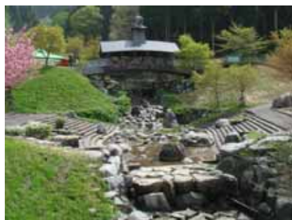
親水性を配慮した階段護岸を整備 (後世川 / パーク獅子吼)
