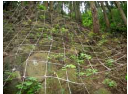
既存樹木を残して山腹面をロープネット工により復旧（白山町）
