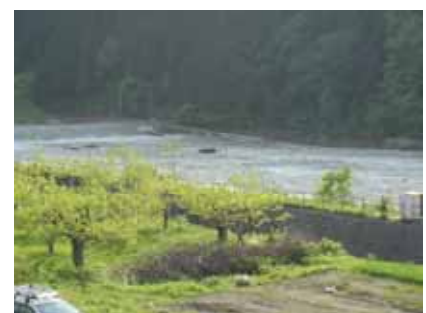
魚道が設けられている手取川の白山頭首工（白山町）
