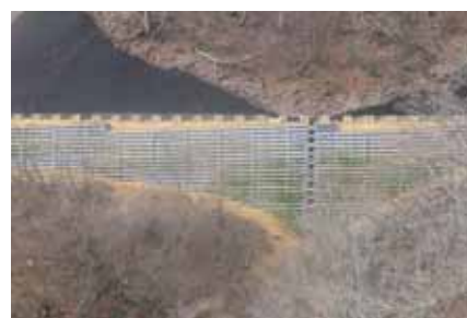
間伐材を用いた擁壁（白木峠線）
