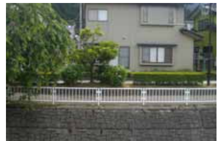
高橋川に設置された縦柵の転落防止柵 (鶴来本町)
