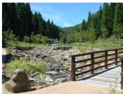
現地の自然石を取り入れて護岸を整備 (上出合川 / であいふれあい公園)
