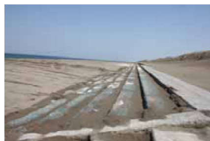
海岸景観に圧迫感や違和感を与えないよう配慮した階段式緩傾斜護岸 (松任C.C.Z.)
