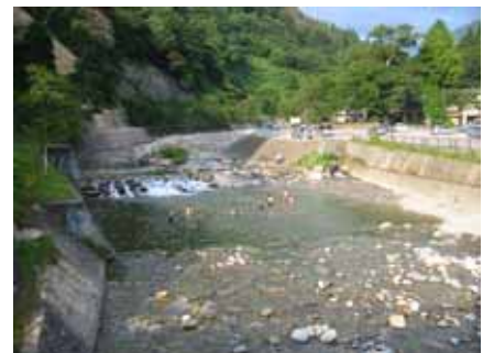
部分的に階段護岸を整備し、親水性を確保するとともに、単調な景觀に変化を与えるよう工夫（直海谷川）
