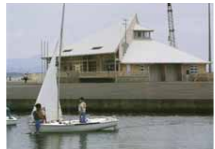
マリーナに浮かぶヨットの帆をイメージして管理棟の屋根をデザイン (滝港マリーナ / 羽咋市)
