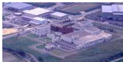
芝生や植栽などを設置し、周辺景観に配慮（松任中央浄化センター）
