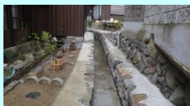
■基幹事業:高質空間形成施設 石積水路(ミンジャ)整備
