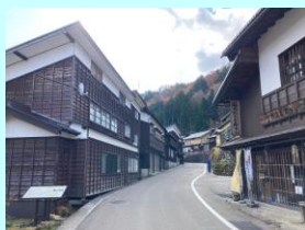
■基幹事業:高質空間形成施設 白峰中央通線無電柱化
