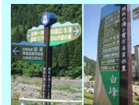
■基幹事業:地域生活基盤施設 案内標識等改修(6基)
