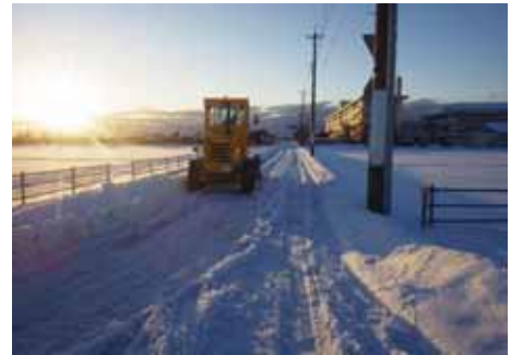
道路の除雪作業
