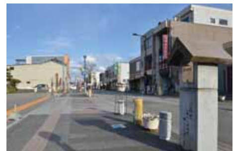
無電柱化した千代尼通り商店街
