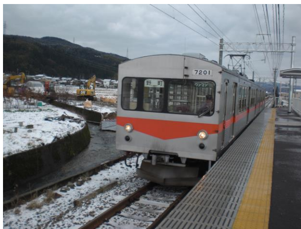
工事中の陽羽里駅を通過する野町駅行電車
