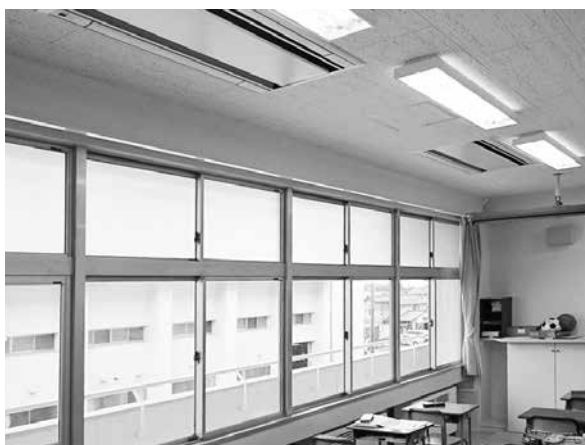
教室に設置したエアコン
