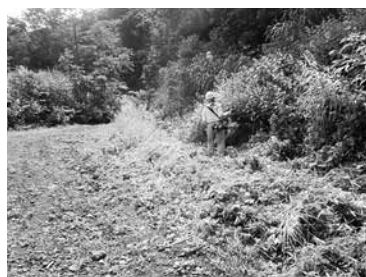
緩衝帯の設置
