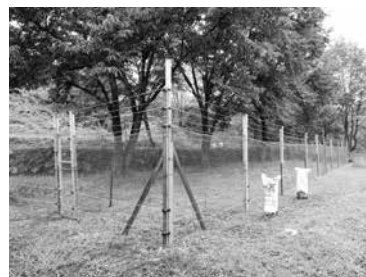
防護柵の設置
