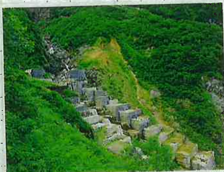
白山千取川沿いの砂防工事 Webページより
