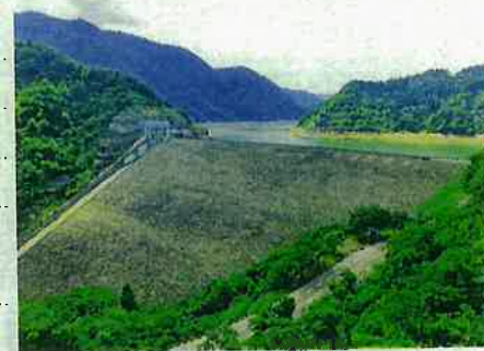
Webページ「千取川ダム」より
