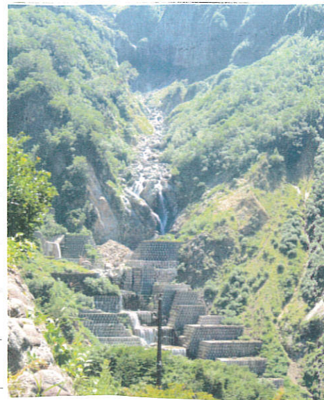
⑥工事の様子
