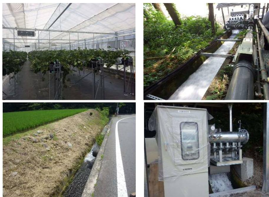
図 3-11 栽培ハウス（左上）と取水源の農業用水（左下）および発電設備（右上、下）
